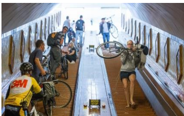
Foto 3-4: Roltrap Sint-Annatunnel (bron: Het Nieuwsblad)
