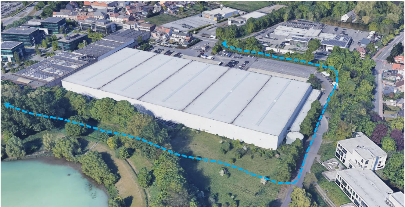
Figuur 188: foto huidige toestand met aanduiding tracé nieuwe open bedding van de Trawool
