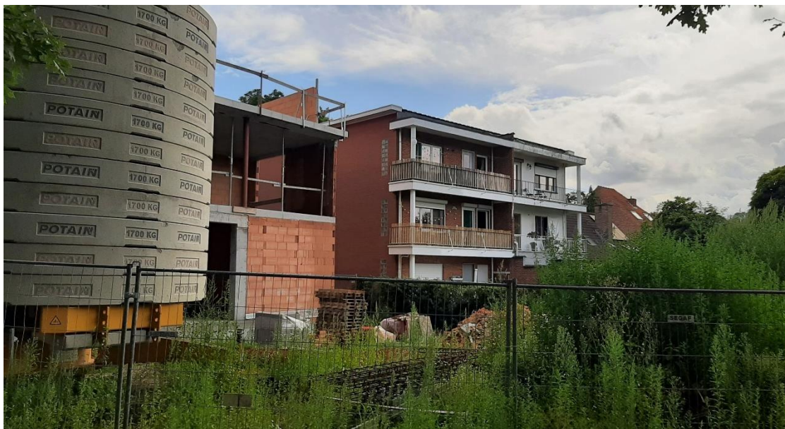
Figuur 13-71 Achterzijde van de woningen langs de Zemstbaan (eigen foto, 2021)
