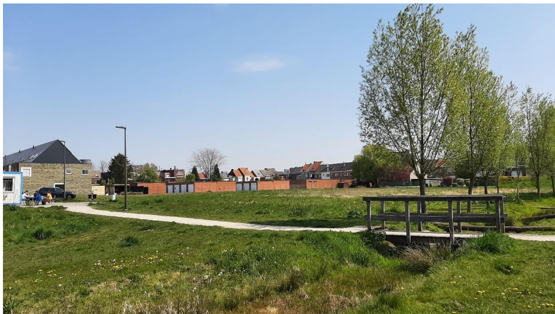
Figuur 11-28: Zicht van in het park richting de bebouwing van de Berthe Seroenstraat, met centraal in beeld het pad doorheen het park, met een brug over de wadi/gracht die door het park slingert.
