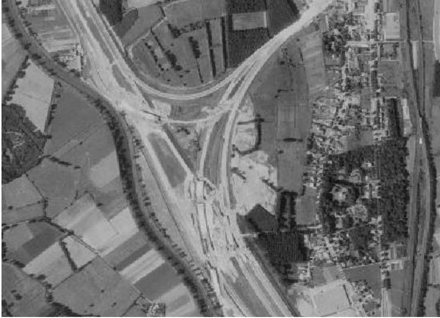
Figuur 12-35 Deelgebied 'Technopolis' ten tijde van de aanleg van de E19
