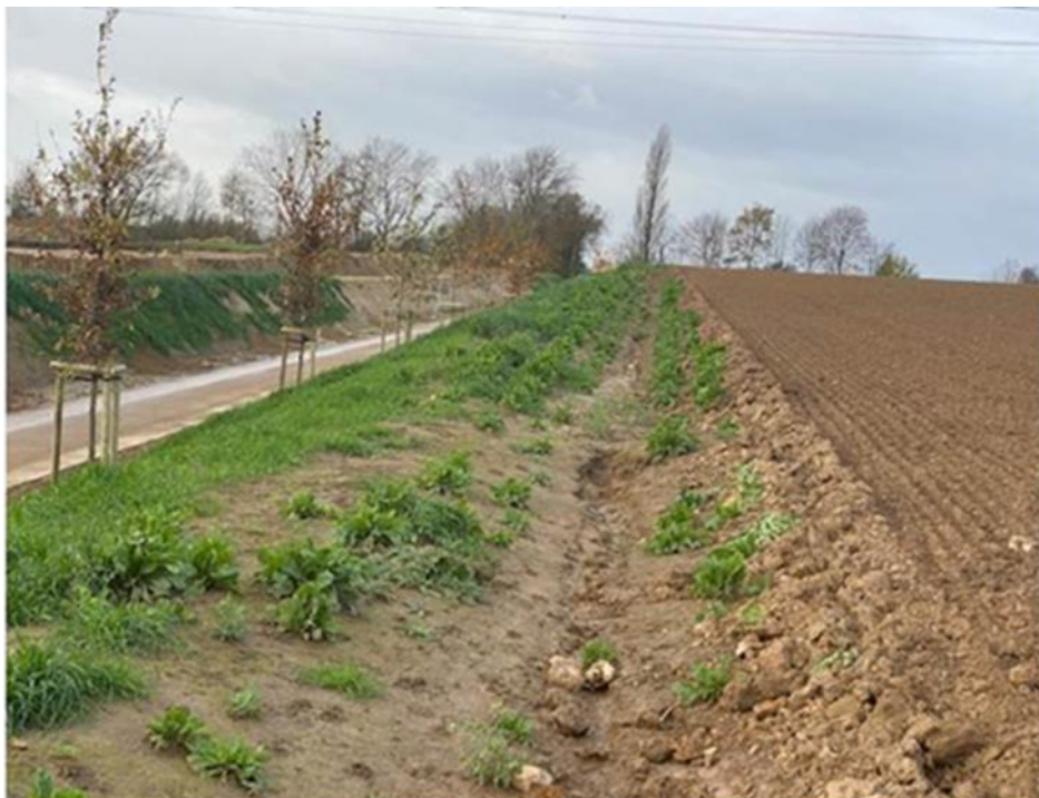
Figuur 9 Verlegde Schildstraat (holle weg) en bufferstrook van 3 m met gracht om erosie tegen te gaan.
