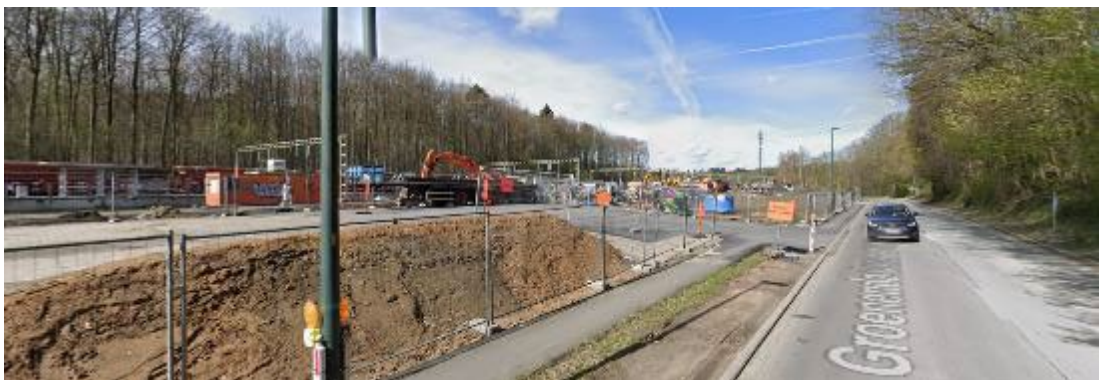
Figuur 11-17: Bestaande toestand (voorjaar 2023) tussen Groenendaalsesteenweg en spoorweg (herinrichting omgeving station Groenendaal in uitvoering door NMBS)
