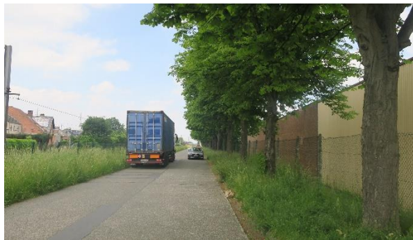
Foto van op de Zwalmkouter richting het station van Erembodegem in het noorden. Links loopt de spoorweg met daarlangs woningen. Rechts is achter de bomenrij een blinde muur zichtbaar van de huidige bedrijfsgebouwen.
