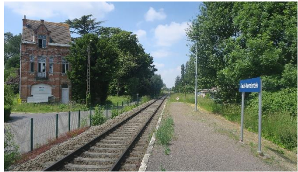
Zicht van op het perron van het station Kerrebroeck. Links biedt een parallelweg aan de spoorweg toegang aan een achterin gelegen woning en het plangebied.
