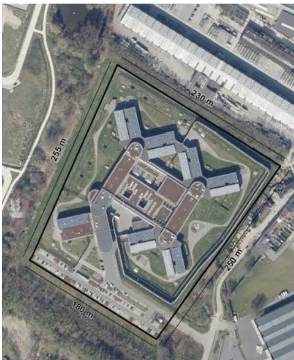
Luchtfoto van het FPC in Gent met aanduiding van de afmetingen van het perceel.
