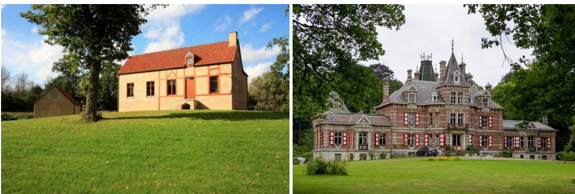
Figuur 6-6. Hoeve 't Bergske en Hof Ter Laken
