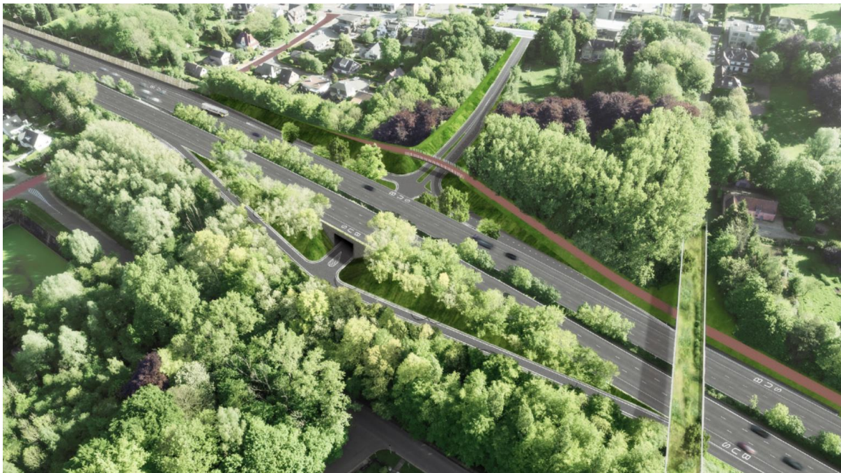
figuur 4: ideeschets voor één van de mogelijke oplossingen voor Jezus-Eik oost uit het Projectboek R0 Oost
