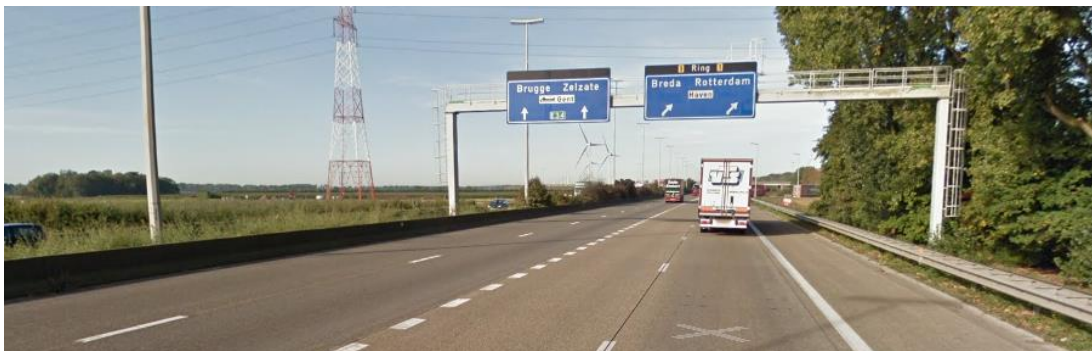
Figuur 3-38: E34 tussen wisselaar R2xE34 en complex Melsele komende vanuit het oosten
