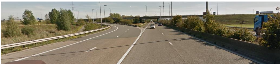
Figuur 3-37: Wisselaar komende van het oosten (oprit)
