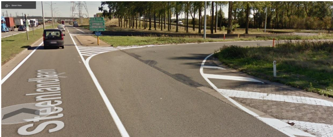
Figuur 3-41: Oprit richting Zelzate vanaf de Steenlandlaan
