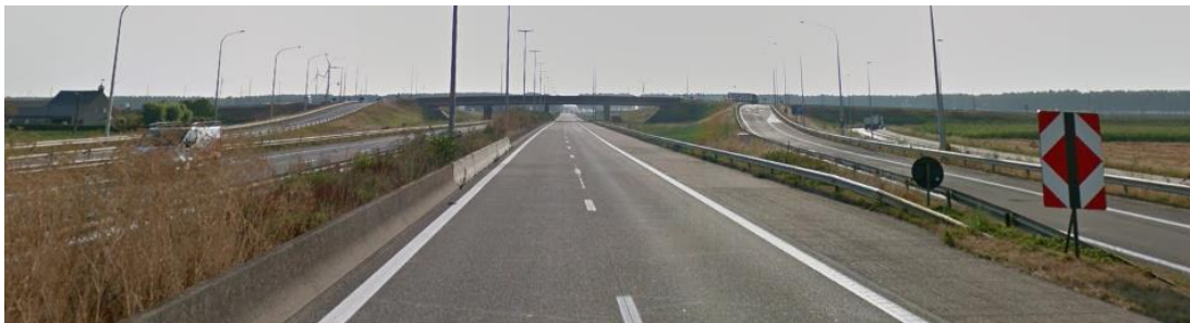
Figuur 3-33: Complex Vrasene komende vanuit het westen
