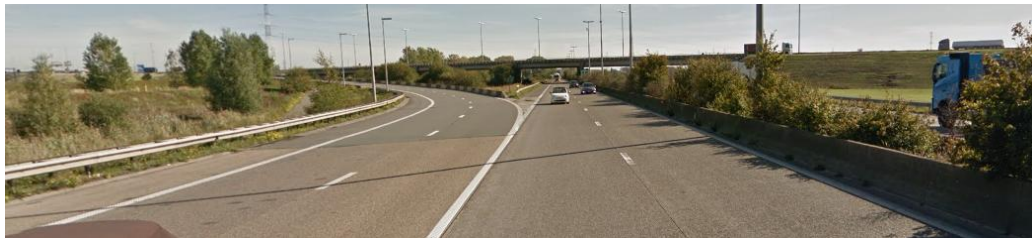
Figuur 4-20: Wisselaar komende van het oosten (oprit) (Bron: Google Maps)
