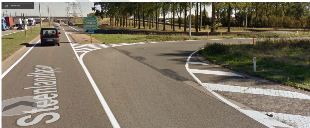
Figuur 24: Oprit richting Zelzate vanaf de Steenlandlaan (Bron: Google Maps)
