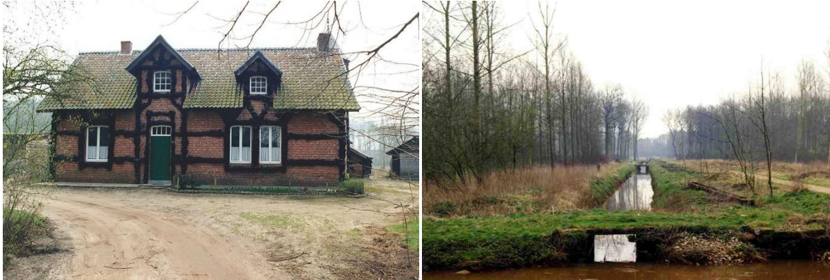
Figuur 23. Boswachterswoning en sluis- of stuwsysteem Trammetje
