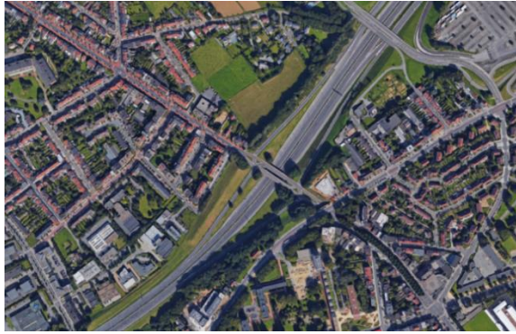
Foto 5: Aansluitingscomplex 8 Wemmel (bron: www.google.be/maps )
