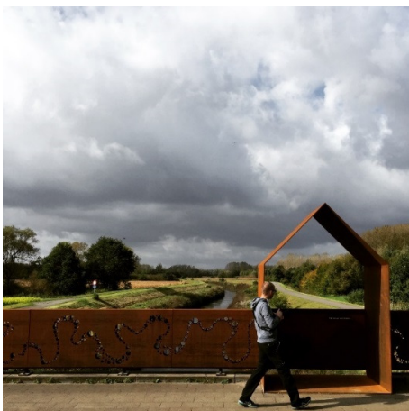
Figuur 10: Tolhuis – brug te Betekom (2017)
