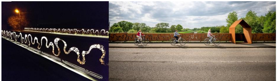
Figuur 43. Tolhuis – brug te Betekom, 2017
