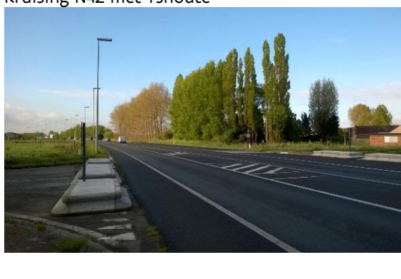
N42 thv. kruising met Kwaadbeek (afgesloten wegen – Kwaadbeekstraat)
