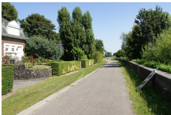
Foto 7-33 Woningen t.o.v. de bestaande keermuur te Gentbrugge (Nijverheidskaai)
