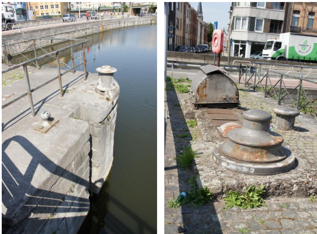
Foto 7-6 Bewaarde kaaimuur en sluismechanisme (opwaartse deur)
