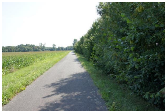
Foto 7-34 Begroeiing op de dijk (bestaande toestand)
