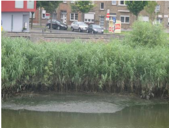
Foto 7-1 Rietkraag en slik ter hoogte van kademuur Gentbrugge
