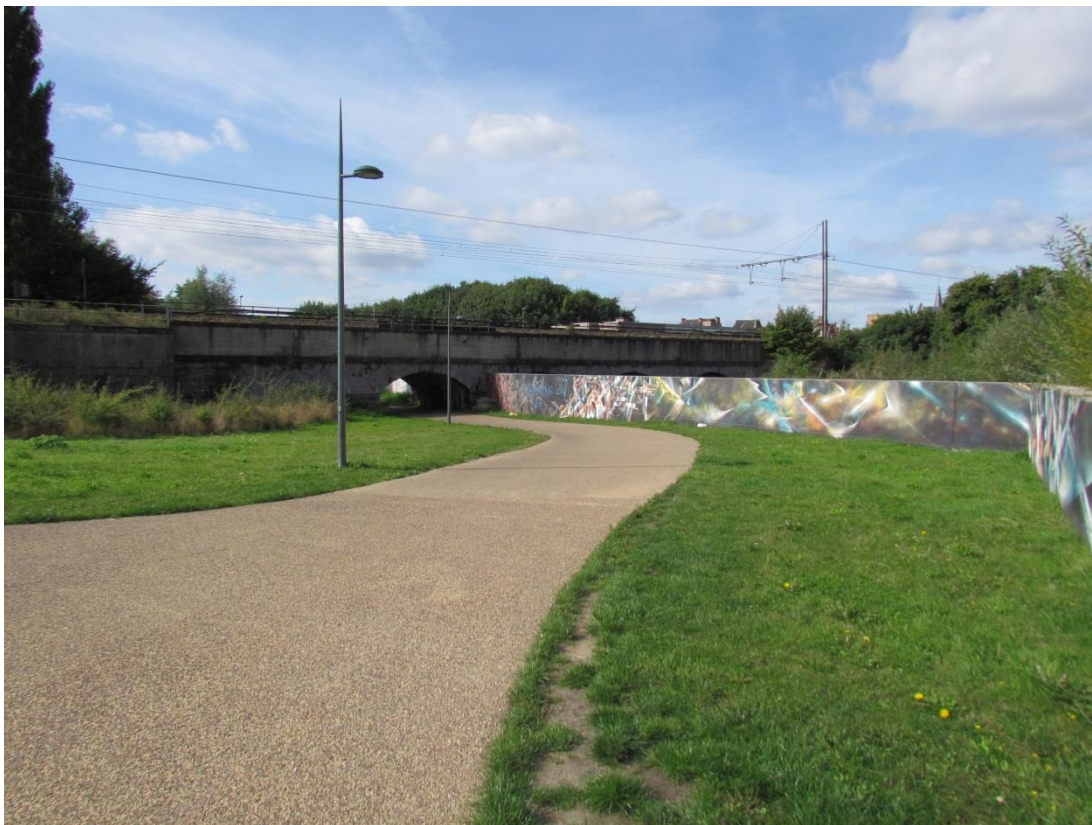
Foto 7-42 Overzicht bij spoorwegonderdoorgang en keerwand te Gentbrugge
