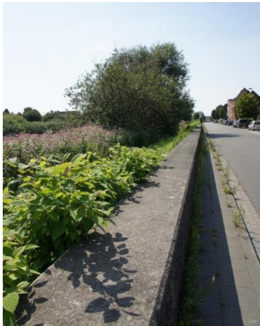
Foto 7-7 Keermuur ter hoogte van de Nijverheidskaai
