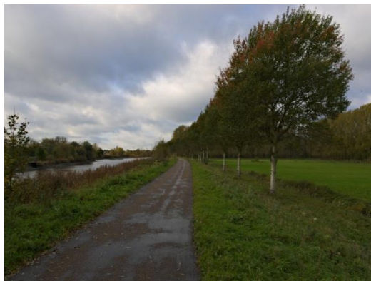
Foto 2-7 Ham – jaagpad Scheldedijk (zicht naar stroomopwaarts)
