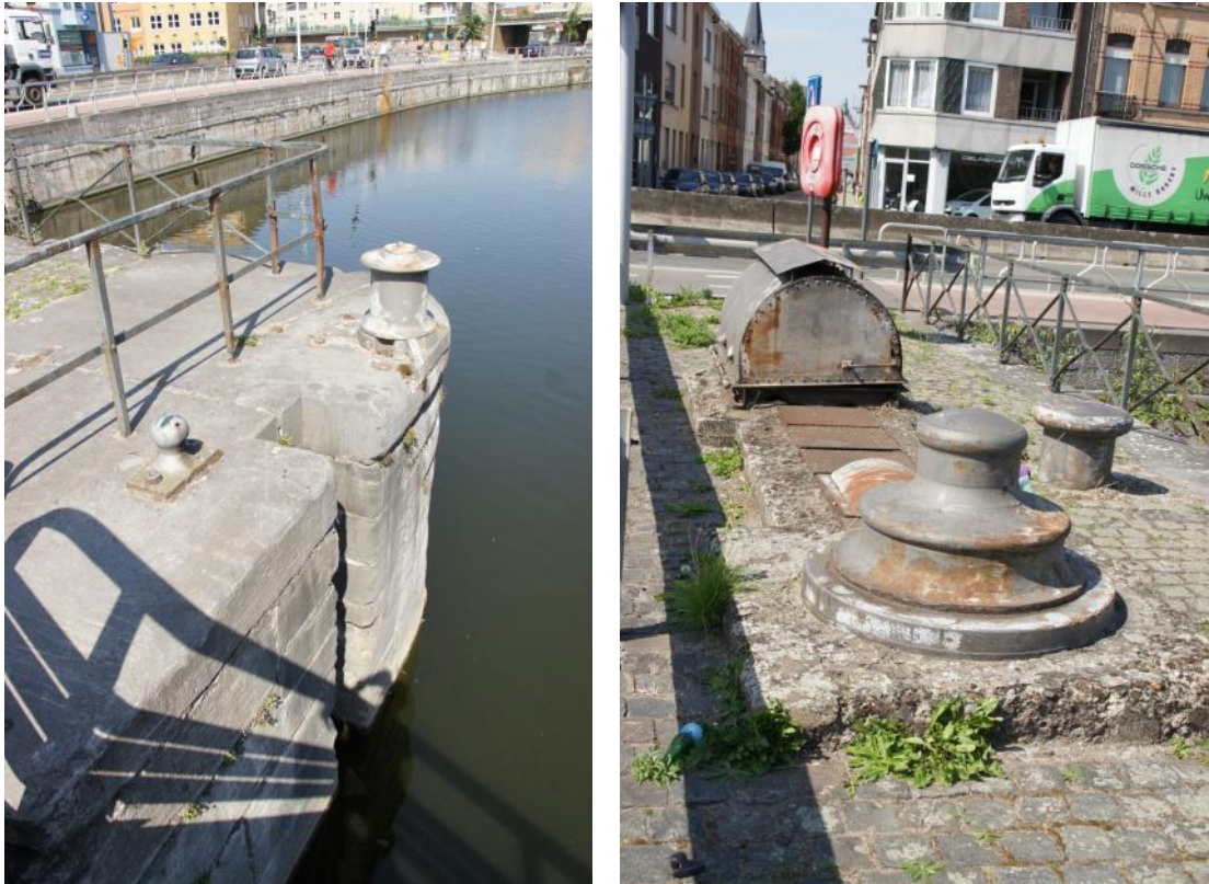
Foto 7-6 Bewaarde kaaimuur en sluismechanisme (opwaartse deur)
