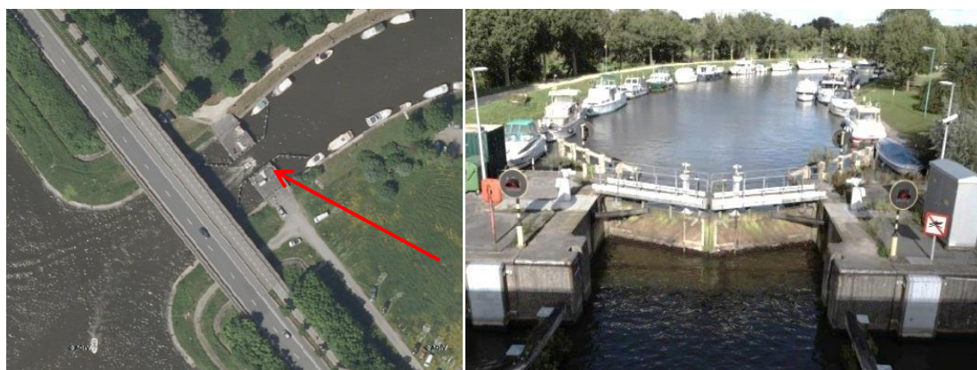
Figuur 5-7 Keersluis K2 tussen Ringvaart en Gentse binnenstad ter hoogte van de monding van de Toeristische Leie (links : geopende stand (bron: google earth), rechts : gesloten stand (bron : www.nieuwsblad.be ). De keersluis K2 dient enkel ter bescherming tegen overstromingen of tijdens calamiteiten (olielek).
