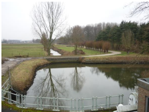
Foto 2-6 Bastenakkers – pompstation van Voorde en bufferbekken (zicht vanop Scheldedijk)
