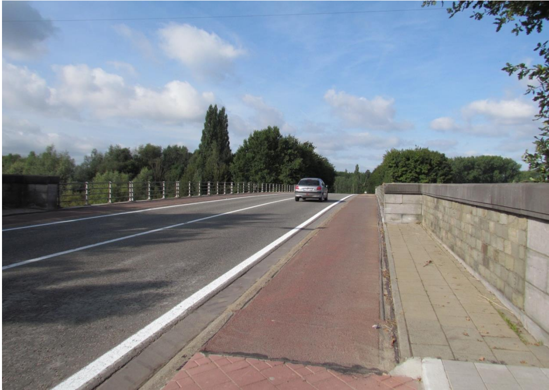
Foto 7-37 Huidige langzaam verkeersinfrastructuur op Heusdenbrug
