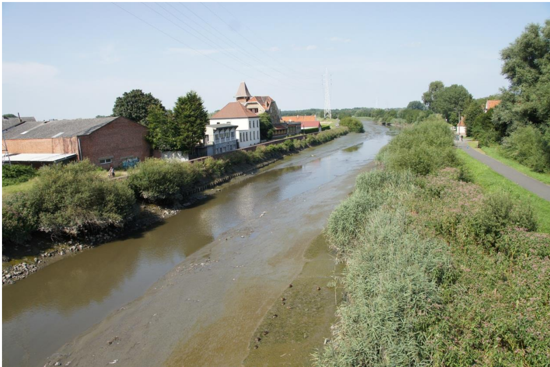
Foto 7-35 Landschap ter hoogte van de nieuw te bouwen sluis
