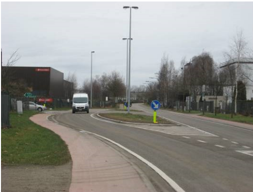
Kruispunt Dellestraat x E313 complex 26a (afrit vanuit Hasselt / oprit richting Antwerpen)
