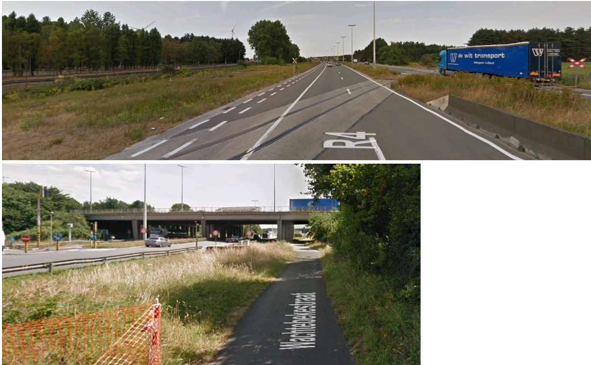
Figuur 8 Bestaande fietsinfrastructuur: aanliggende fietspaden langs de R4 en kruising spoorlijn L204 (boven); fietspad langs de R4 t.h.v. de E34 in het verlengde van de Wachtebekestraat (in geplande situatie ook te gebruiken door de bussen van De Lijn) (onder)
