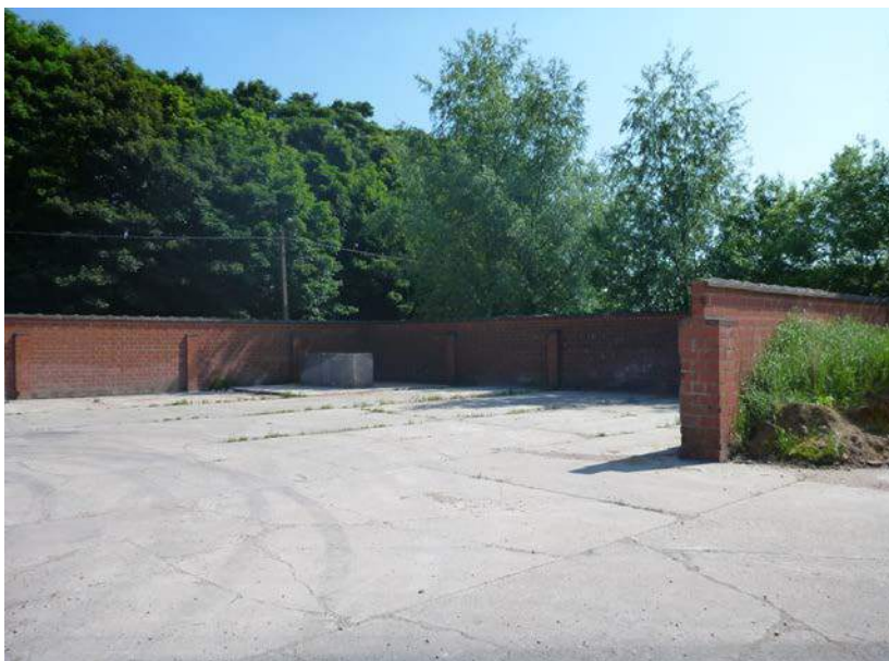
Foto 12 Verharde zonde rond gebouw AMT
