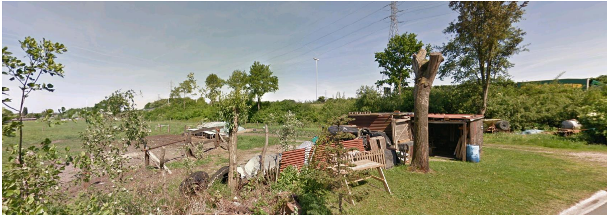
Zicht op het talud van de R4 vanaf de Kiekenbosstraat
