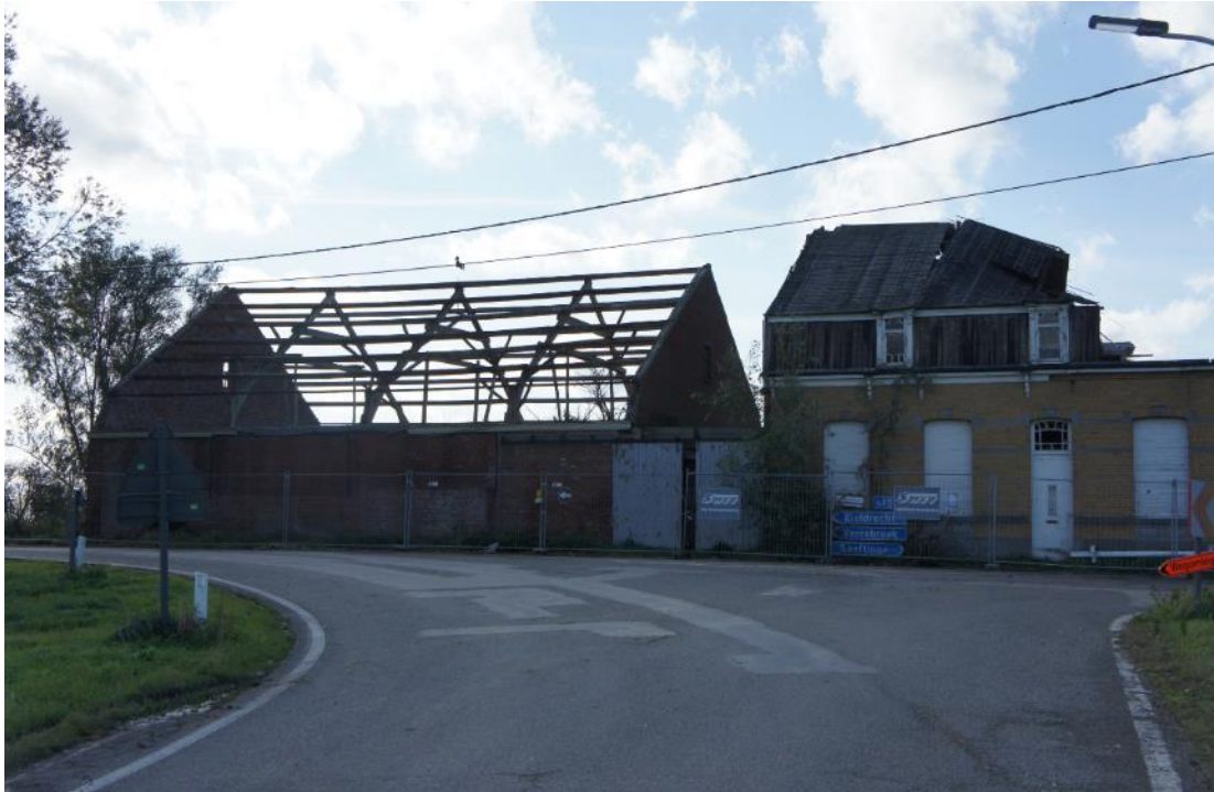
Sloop van een dubbelhuis in Saftingen (2011, eigen foto)
