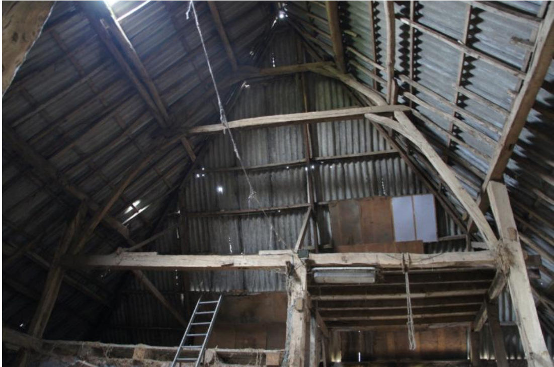
Figuur 289 Schaargebinte in de schuur (actuele toestand) (eigen foto)
