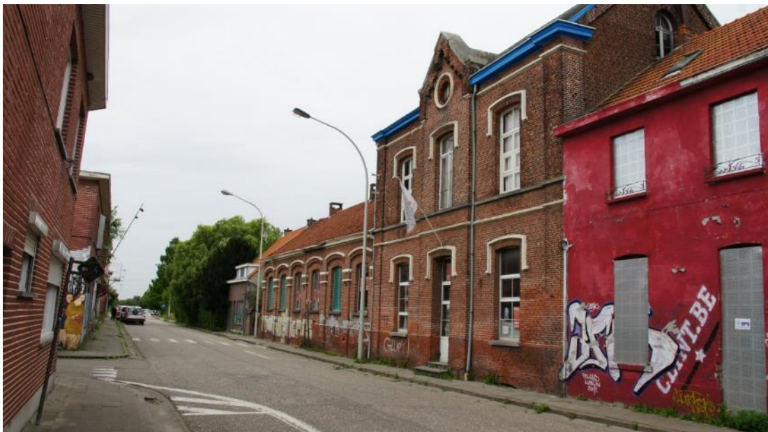
Figuur 263 Schoolgebouw toestand 2007 (Foto VIOE), actuele toestand (eigen foto)
