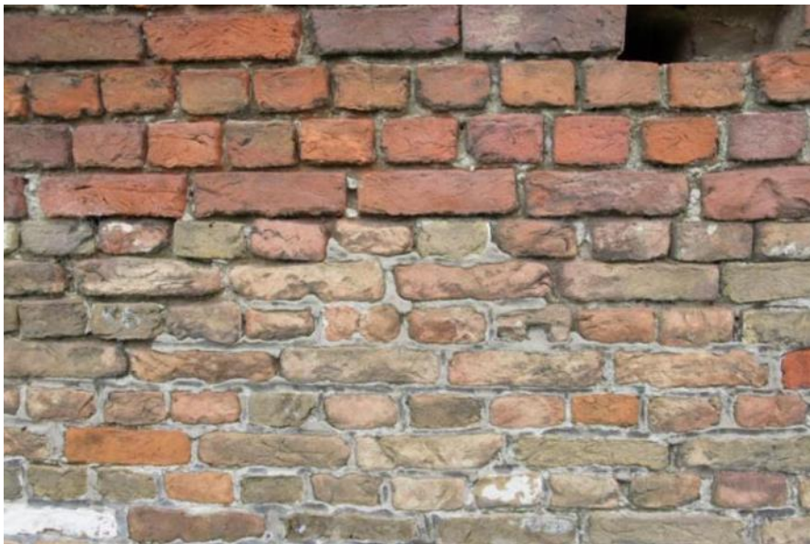
Figuur 283 Metselwerk Olifanthoeve (detail) (eigen foto)
