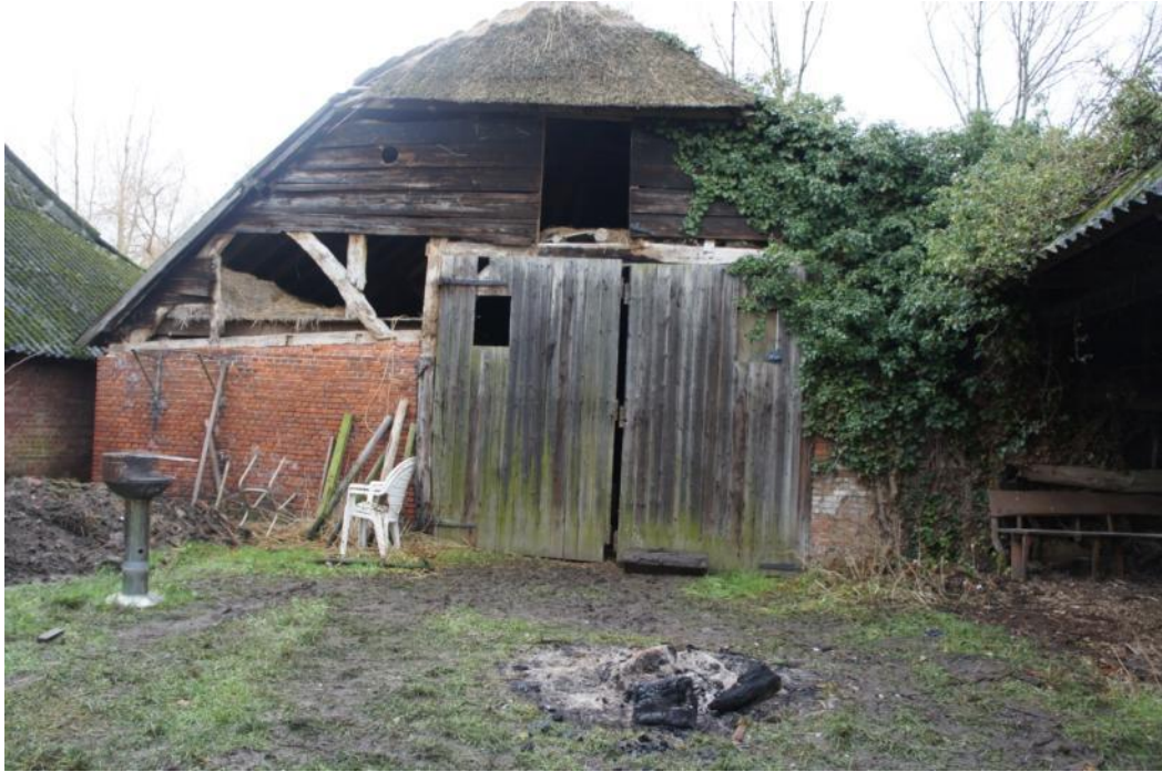
Figuur 296 Oud Arenberg 111: kleine schuur (oostgevel) (eigen foto)
