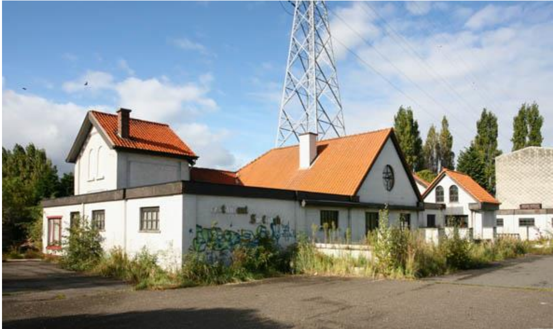
Figuur 267 Station van Doel (toestand 2007, foto VIOE) Bij de verbouwing tot discotheek werd het oorspronkelijke gebouw volledig ingekapseld.
