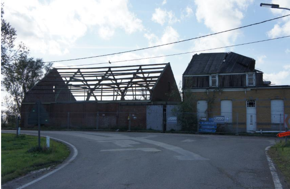
Figuur 318 Sloop van een dubbelhuis in Saeftinghe (2011, eigen foto)
