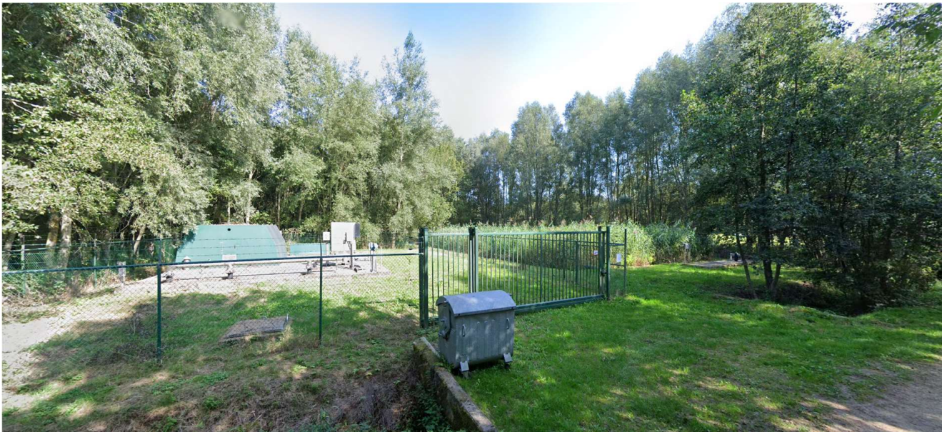
figuur 22. Voorbeeld van hybride systeem (biorotor 450 m² binnen omheining + percolatierietveld 500m²) voor +/- 100 panden © Google Street View
