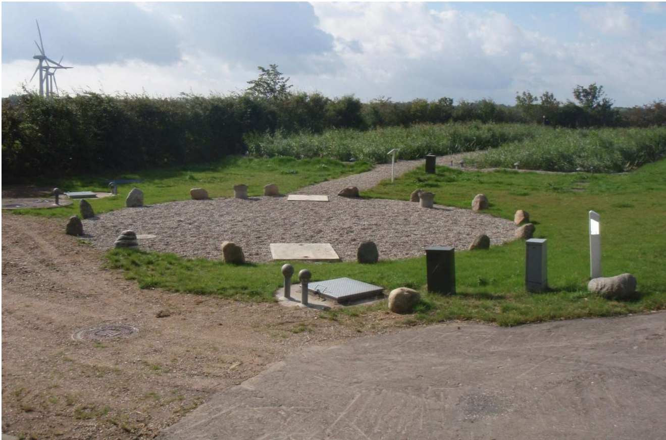
figuur 23. Voorbeeld van percolatierietveld (1000 m²) voor +/- 80 panden © Kilian Water
