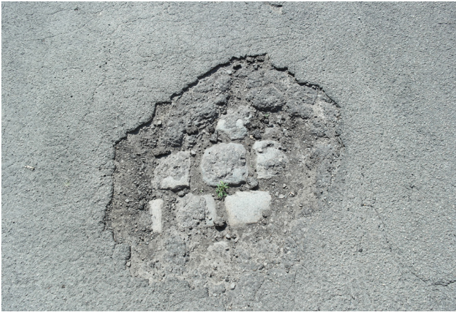
figuur 45 Onder het afgebroken asfalt komen de historische kasseien van de straten in Doel opnieuw tevoorschijn.
