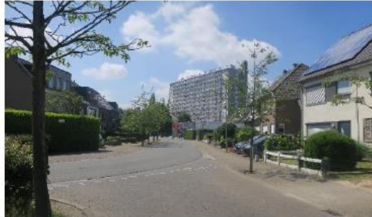
Kruispunt Lindenstraat met Raffelgemstraat met 1 van de woontorens in het zuidwesten van het plangebied.
