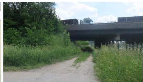
Foto richting de E40 ter hoogte van Zwalmkouter. De aarden weg gaat onder de brug over in een smalle voetweg. Links op de foto is een deel van de bufferbeplanting te zien tussen de E40 en Zwalmkouter.
