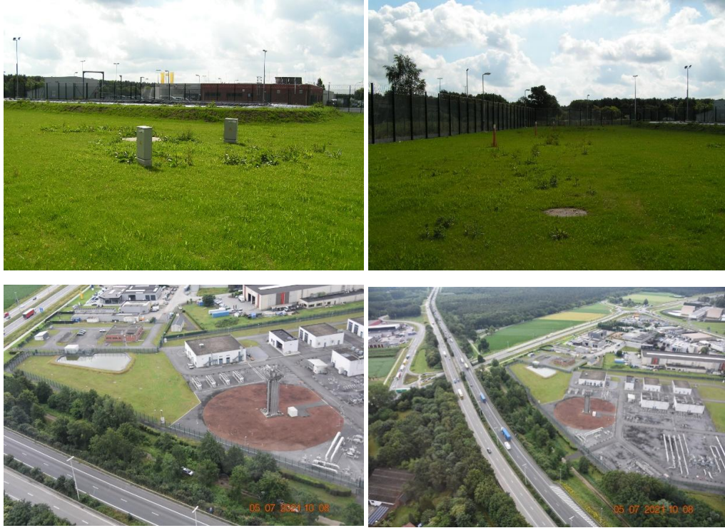
Figuur 6-68 Foto's compressiestation te Zelzate
