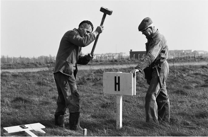
Eerste bouwwerken op de site. (Bron: www.nato.int )
