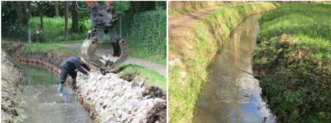
Afbeelding: Voorbeeld van de 'Voer', waar een gelijkaardige natuurvriendelijke oever is aangelegd (bron: dienst Waterlopen prov. Vlaams-Brabant)
