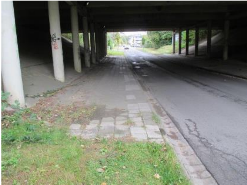
Foto: Viaduct Esdoornenlaan te Overijse
