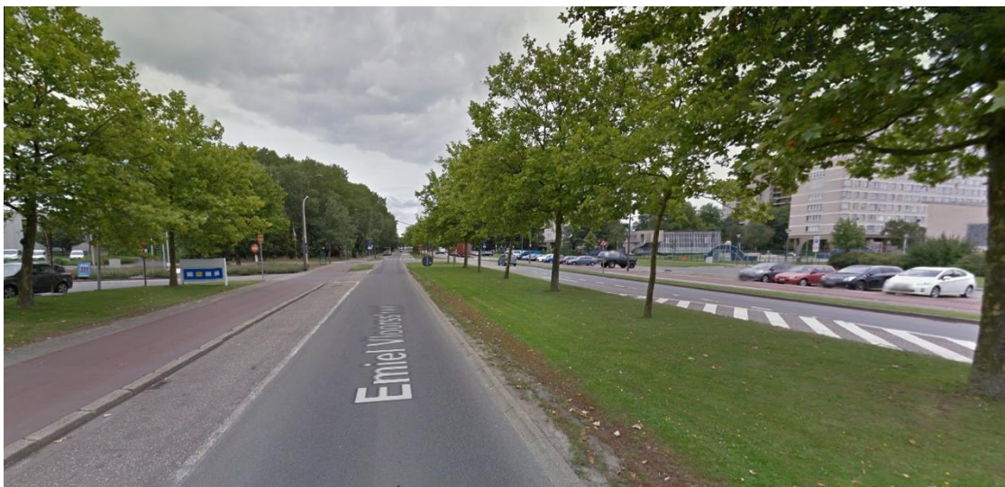
Figuur 53 Gescheiden fietspaden langs de Emiel Vloorstraat, bron: Google Street View
