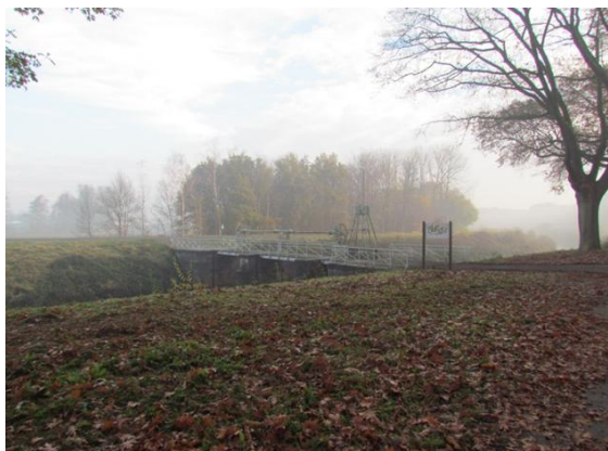
Brug t.h.v. het Derde Sas
