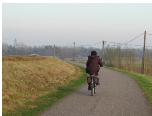
Noordelijke weg in dijkhelling
