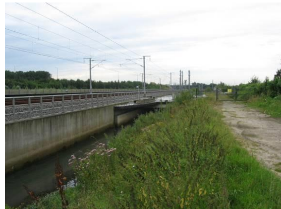
Figuur 8.6: Laarse beek in betonnen kanaal
