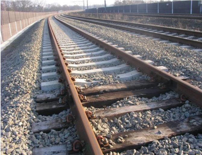
Figuur 8.19: zicht op de overgang van houten dwarsliggers naar betonnen dwarsliggers ter hoogte van De Noteschelp
