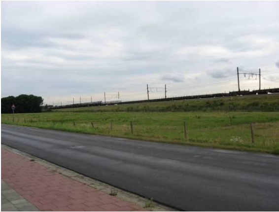
Figuur 10.1 zicht op opgehoogde L27A vanaf straat Oude Landen
