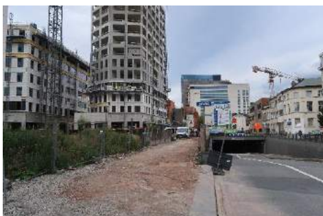
5. Van Immerseelstraat richting Kievit fase I: bouwwerf bouwblok IIb en tunnelmond naar ondergrondse parking
