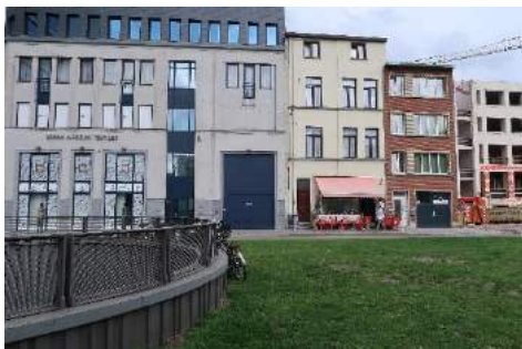
21. Rijwoningen langs Van Immerseelstraat (achter) en lichtstraat ondergrondse parking (links)
