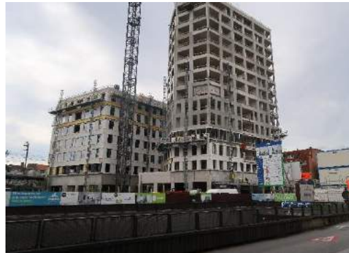
Bouwblok IIb in opbouw
