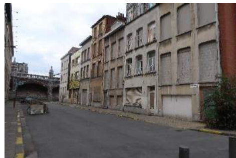
12. Van Sprangenstraat richting spoorwegberm
