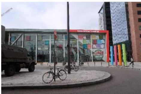
19. Kievitplein richting toegang Centraal Station
