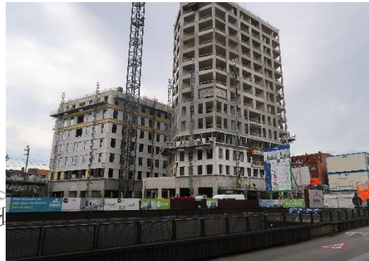
Bouwblok IIb in opbouw
