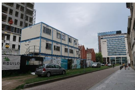
7. Van Immerseelstraat richting werf bouwblok IIb en Kievit fase I
