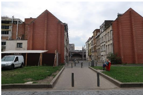
9. Van Immerseelstraat richting Van Spangenstraat tussen bouwblok IIa (links) en I (rechts)
