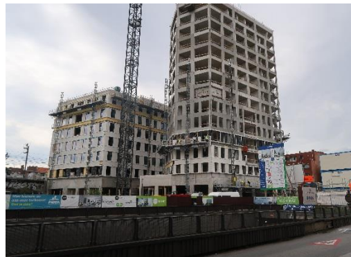
Bouwblok IIb in opbouw
