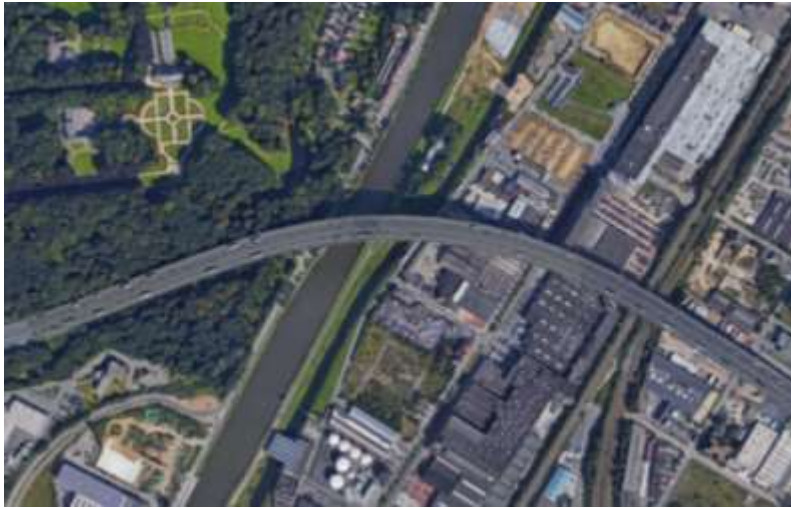
Figuur 64: Viaduct Vilvoorde (bron: www.googlemaps.be )
