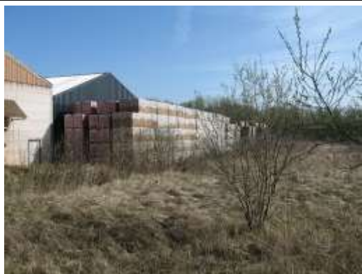
7. zuidzijde fabriekshal met buitenopslag
