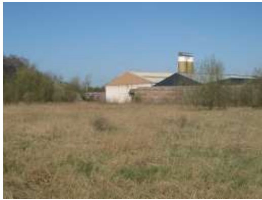
9. fabriekshal in noordwestelijke richting
