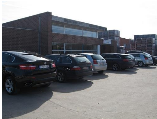
3. parking met toonzaal en kantoren
