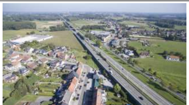
Luchtfoto ter hoogte van Verbindingsweg - Driesstraat, Meise
