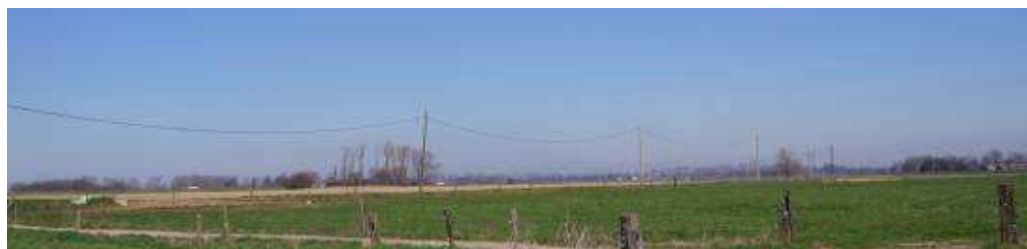
Illustratie 16.55: Elektriciteitspalen langs het noord-zuid tracé Pastoordijk
