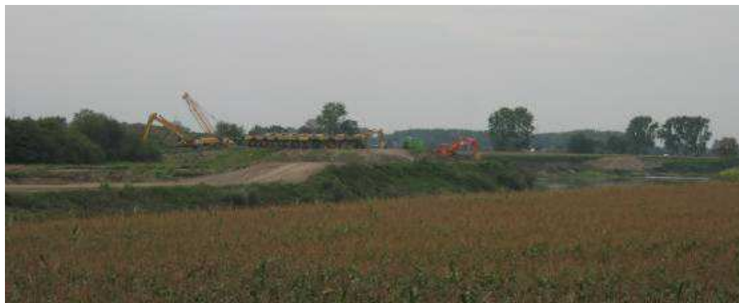
Illustratie 5.4: Werken aan monding Kogbeek, gezien vanaf rechteroever (NL)
