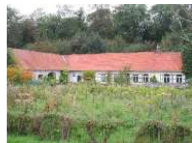
L-vormige hoeve Heirweg 6
