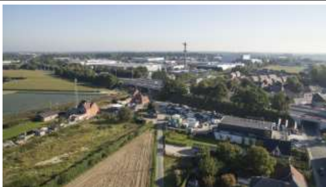
Luchtfoto ter hoogte van de spoorlijn, Londerzeel
