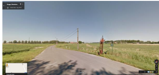
Zicht op noordelijk deel Blankenbergse dijk vanuit zelfde standpunt als hiernaast (bron: google street view)
