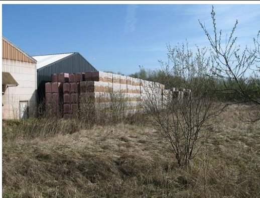
7. zuidzijde fabriekshal met buitenopslag
