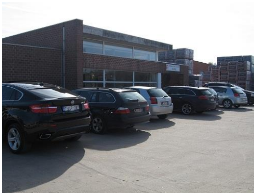
3. parking met toonzaal en kantoren
