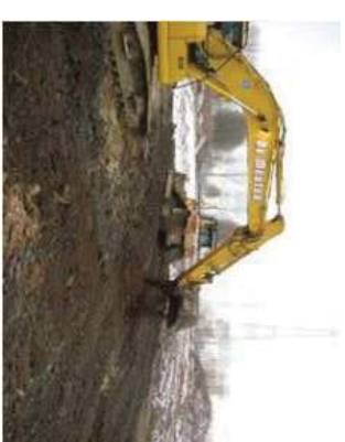
Aanvoer van grond op vaste afkippunten en openspreiden met kranen op rupsbanden
