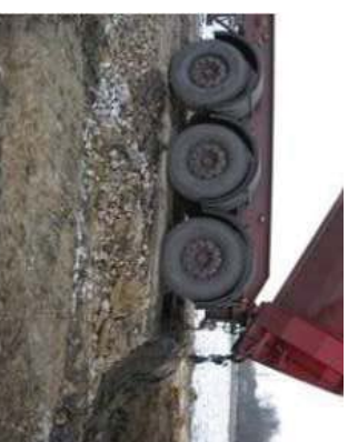
Aanvoer van grond op vaste afkippunten en openspreiden met kranen op rupsbanden
