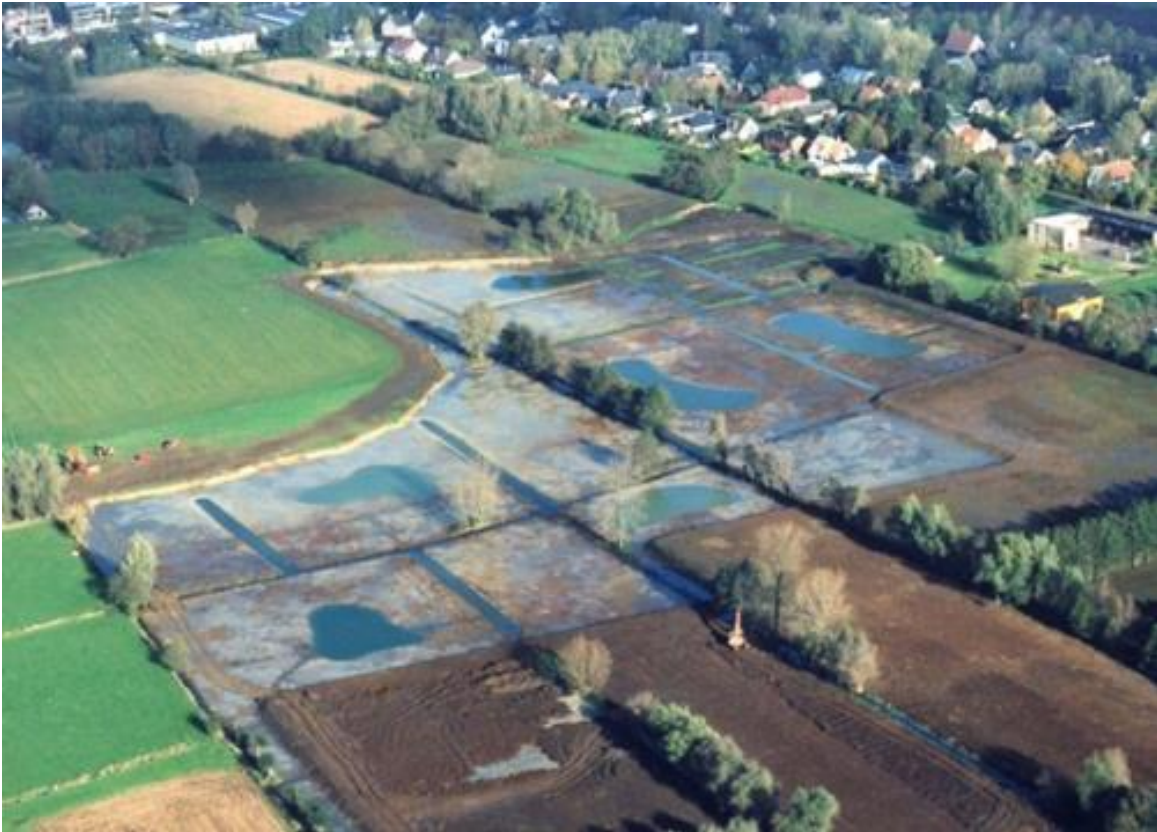
Figuur: luchtfoto van de kronkelende Rosdambeek, het bufferbekken Westerplas en de Westerdijk net opwaarts van het signaalgebied Hooglatem.
