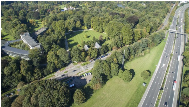
Luchtfoto ter hoogte van de Plantentuin, Meise
