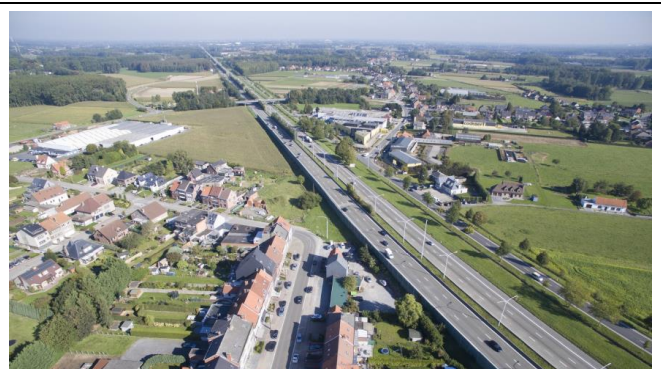
Luchtfoto ter hoogte van Verbindingsweg - Driesstraat, Meise
