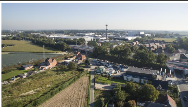
Luchtfoto ter hoogte van de spoorlijn, Londerzeel
