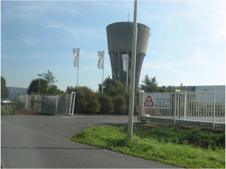
Industriezone TTS ter hoogte van aansluiting Laarstraat
