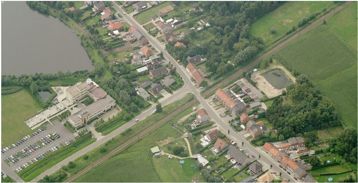
Eigenlotunnel (vanuit oosten)
