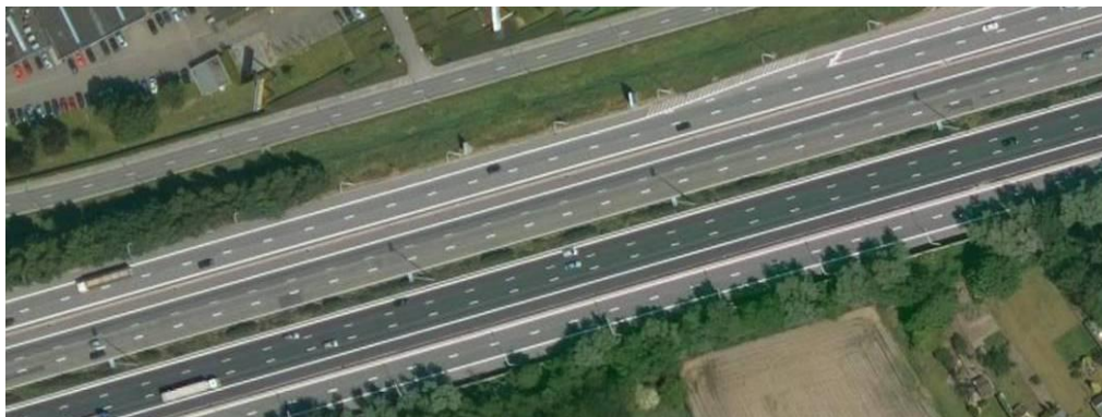
Figuur 8: huidige vormgeving deel N41- brug Hoogkamerstraat
