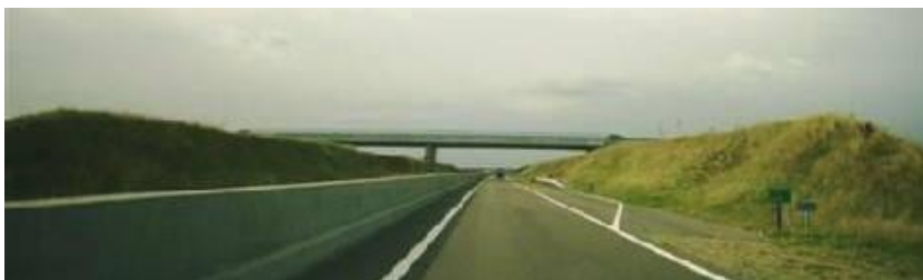
Figuur 15: referentiefoto groene talud
