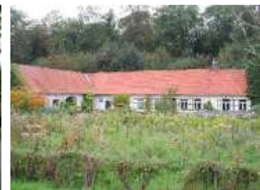
L-vormige hoeve Heirweg 6
